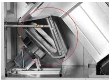
VEX100CF-serien leveres med integreret eftervarmefflade, enten til vand eller el
